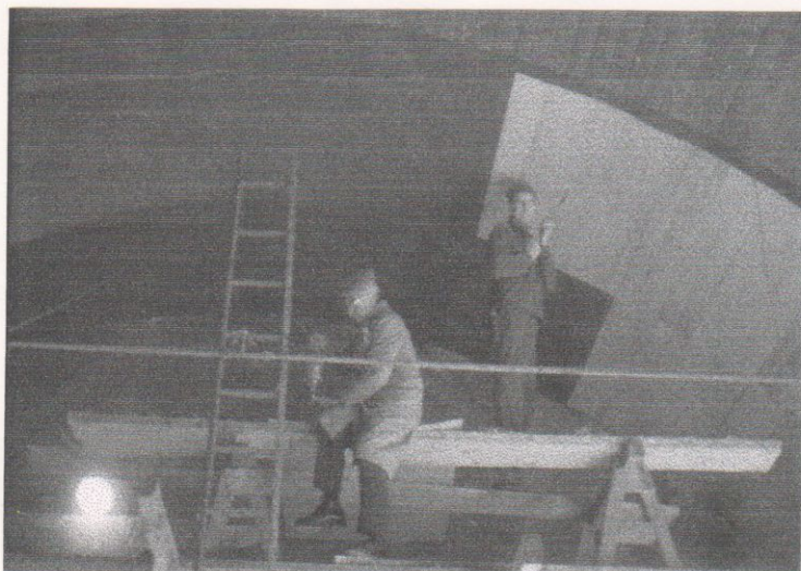
Tischlermeister Berthold Werner und Sohn Wolfgang bei Deckenarbeiten auf dem Saal
